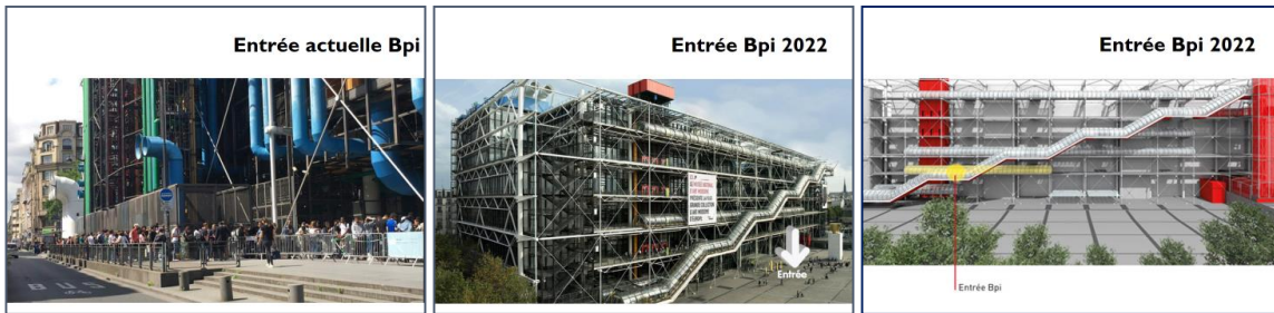
Visuels 6-7-8 : entrée actuelle à la Bpi rue du Renard ; entrée de la Bpi rénovée par la Piazza par le niveau 2
