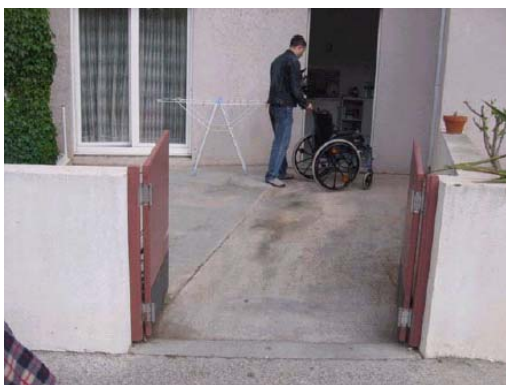
Figure 1 : Entrée de la résidence.
