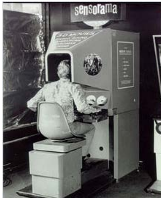
Figure 2 – Le Sensorama de Morton Heilig
