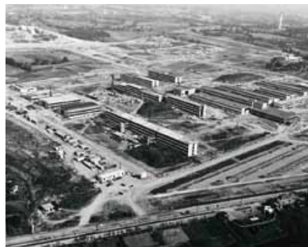
Le chantier du campus de Beaulieu en 1963
